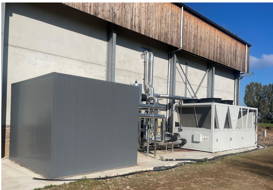
Figuur 8: links de thermische batterij, rechts het propaan koelsysteem met ijswater
