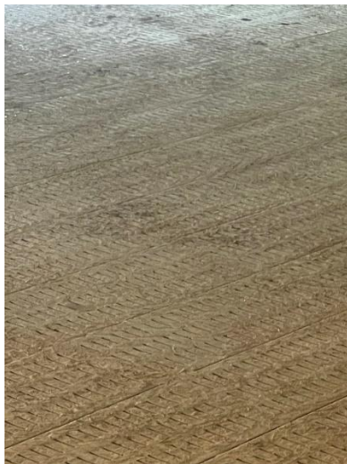
Figuur 5: geperforeerde vloerplaten waar de aardappelen op bewaard worden
