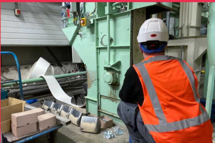
Vervangen van elevatorbanden.
