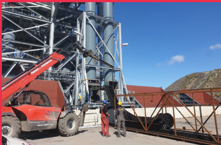
Grote montageprojecten tijdens geprogrammeerde stilstanden : golfbanden vervangen, staakabelbanden vervangen, etc.
