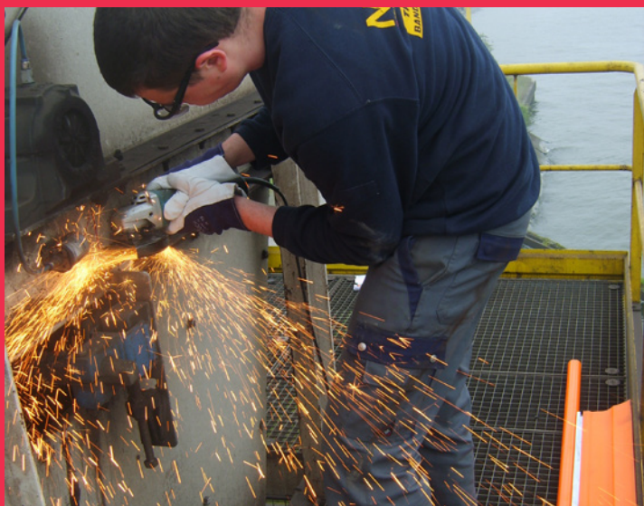
Mechanische werken : afschrapers monteren
