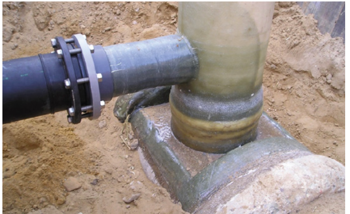
Leveren en herstellen van glasvezelversterkt leidingwerk..
