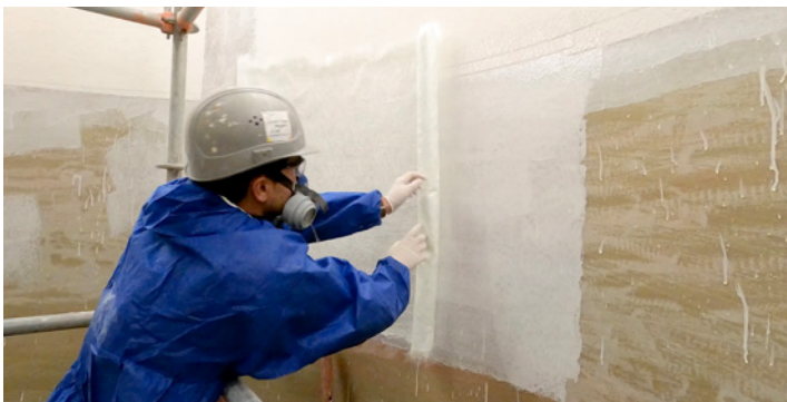
Herstellen en bekleden van tanks en calamiteiten-bakken met glasvezelversterkte polyester en vinylester.
