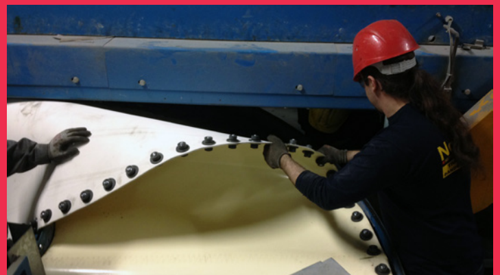
Produceren, monteren en afstellen van rondkleden.
