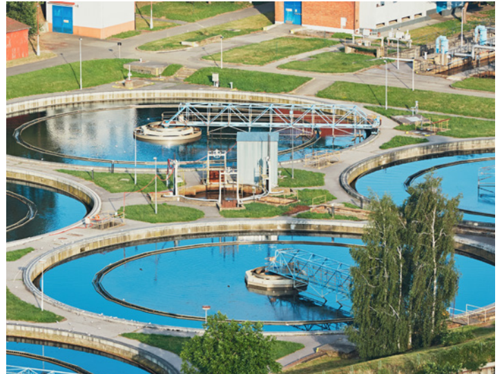
Poly-Urea coating van projecten in de drinkwater en afvalwater industrie.
